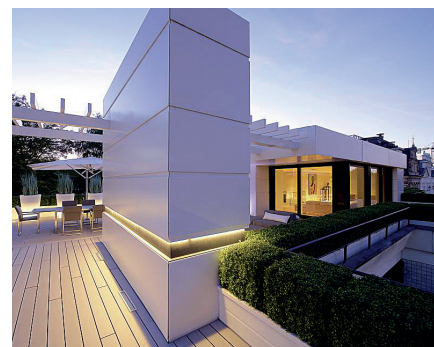
Penthouse, Hamburg, DE © Klaus Stemmler, Material: HI-MACS® - Design: Gerdt Architektur - Fabrication: Kiebitzberg GmbH & Co.KG
